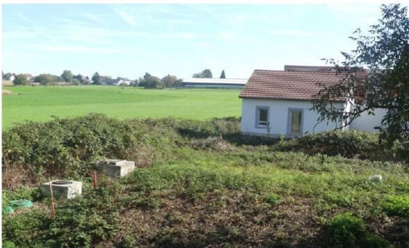
Un poste de relevage, comme celui au bout de la zone des résidences seniors, mitoyenne du lotissement La Marina, à Dannemarie, sert à renvoyer les eaux usées vers le réseau d'assainissement quand celles-ci ne s'écoulent pas naturellement grâce à la gravité. Photo NT.
