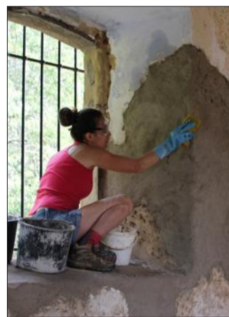
Les bénévoles ont appris à appliquer l'enduit à la chaux sur les murs. Photo L'Alsace
